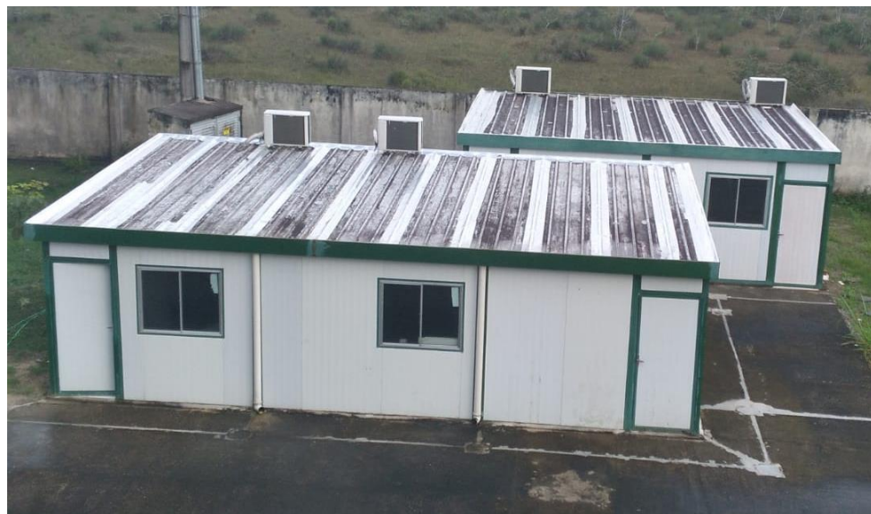
Figura 13: Contêineres locados via contrato 03/2018.
